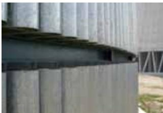
两层消声片之间的间隙照片
