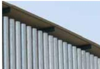
消声片与顶盖板之间的间隙照片
